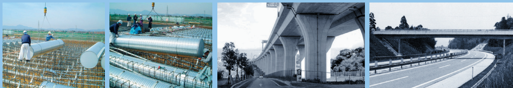
据付中の円筒型枠
