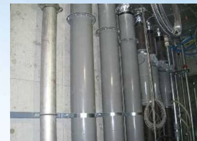
臭突管施工例
