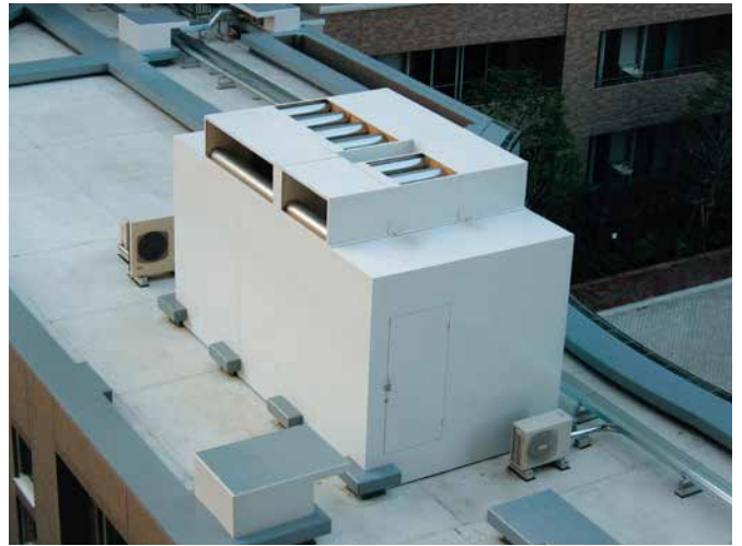
●室外機対策後 全景
