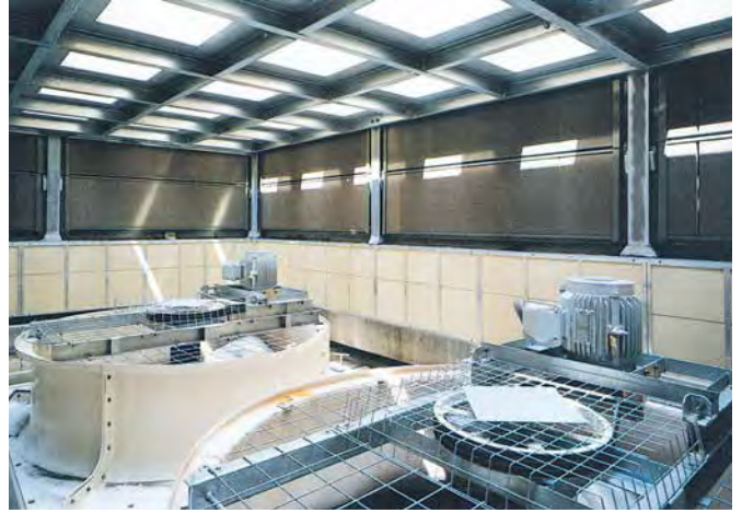
●冷却塔上部(ユニットサイレンサ・セラミックパネル)
