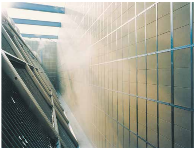
●低圧蒸気復水器置場上部 セラミック吸音パネル取付状況
