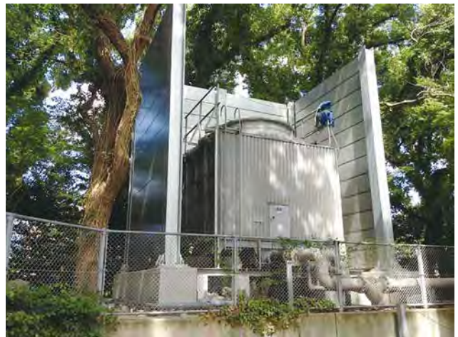
●冷却塔騒音対策
