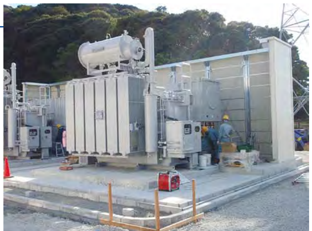
●変圧器騒音対策
