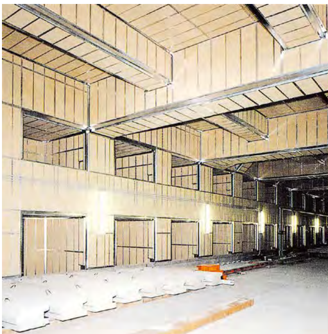
●275kV超高圧地下変電所強制冷却設備消音装置
