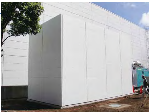
●発電機騒音対策
