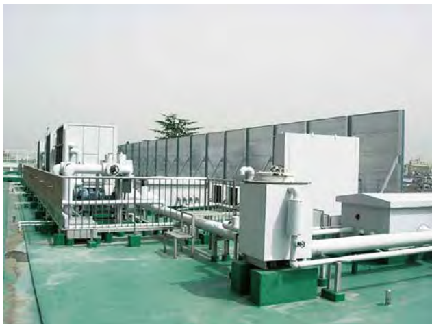
●室外機騒音対策
