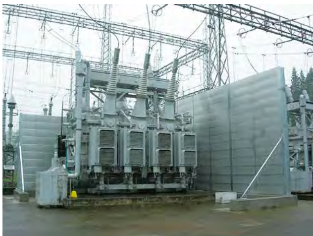
●変圧器騒音対策
