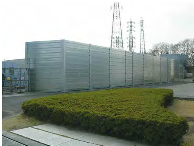
●変圧器騒音対策
