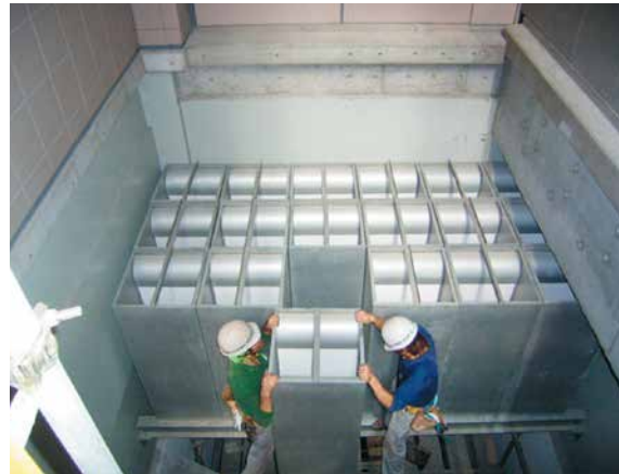
●シャフト内部
