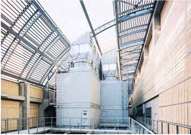
●某ビル冷却塔
