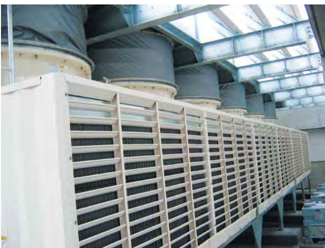
●サイレンサとの接続部
