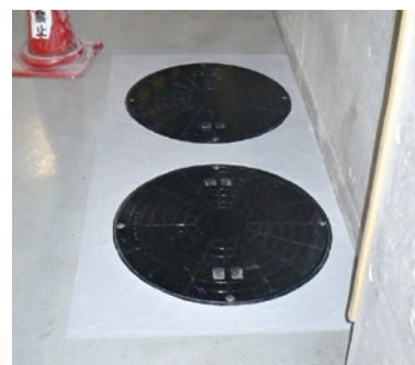
丸形(FRP蓋・FRP受枠)交換後
