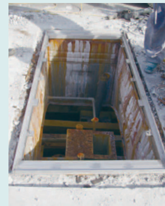
④新しい受枠を設置
