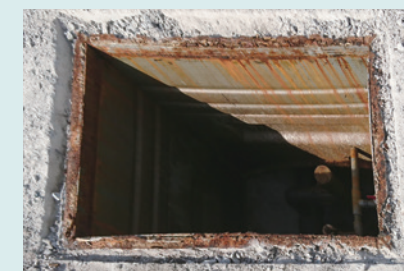
②鉄製蓋・枠取り外し後
