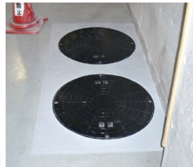
丸形(FRP蓋・FRP受枠)交換後
