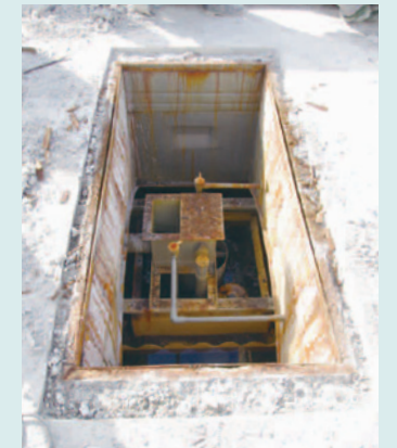
③受枠取り外し後
