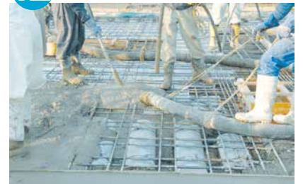
12 コンクリートの打設
