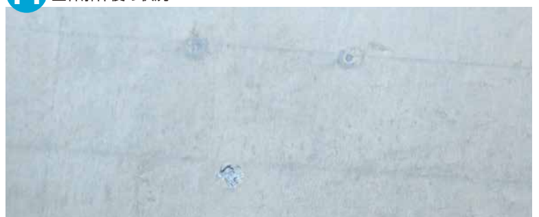
14 型枠解体後の状況
