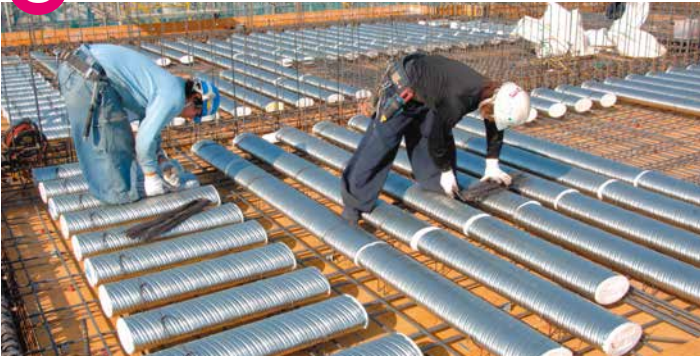
9 ワインディングパイプの据付完了
