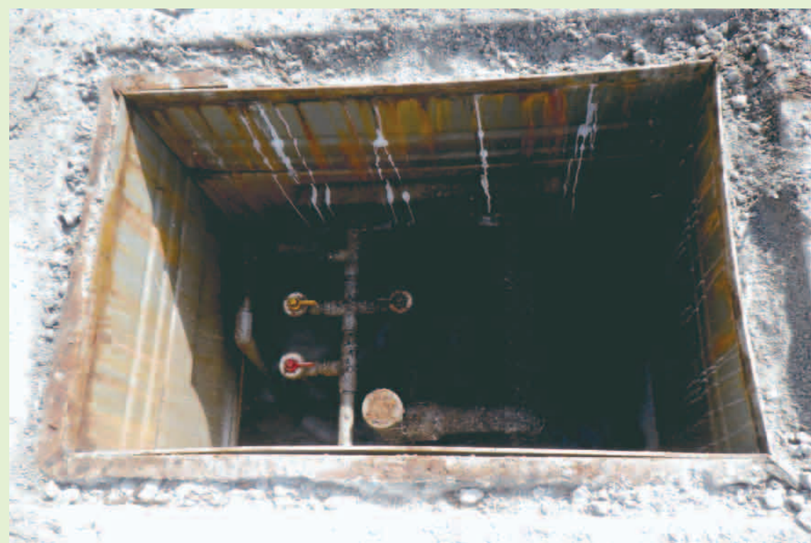
鉄製蓋・枠取り外し後
