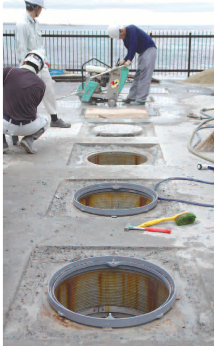
交換工事作業風景
