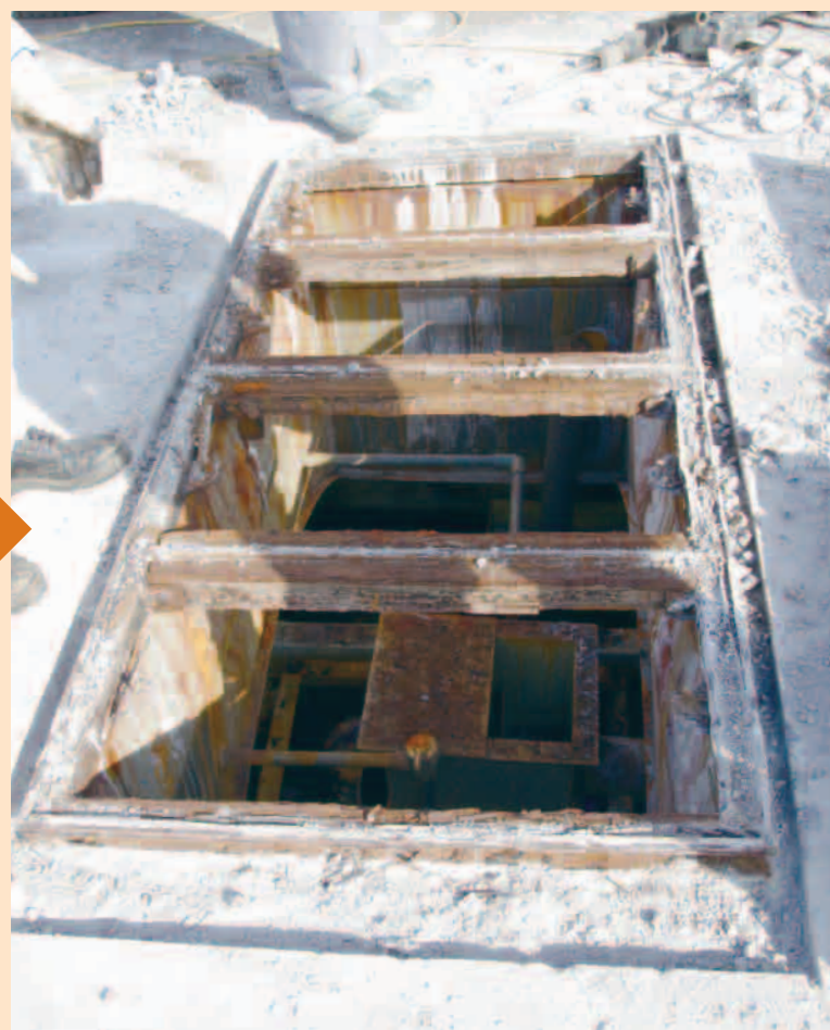
受枠取り外し前
