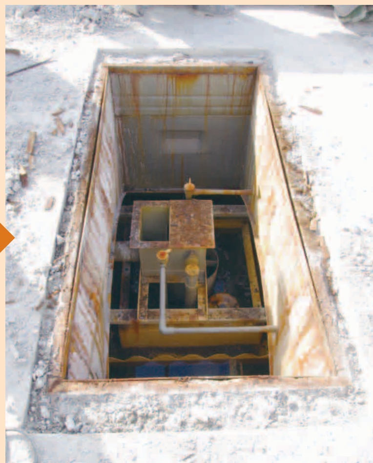
受枠取り外し後
