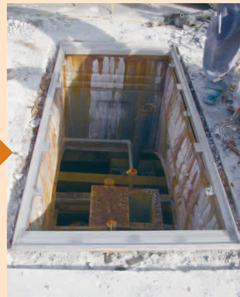
新しい受枠を設置
