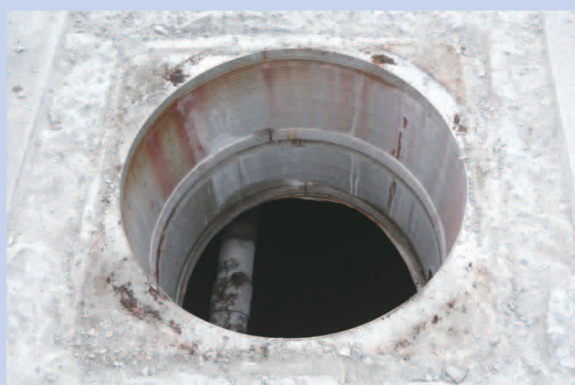
鉄製蓋・枠取り外し後
